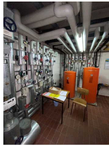
Warmwasser Aufbereitung
