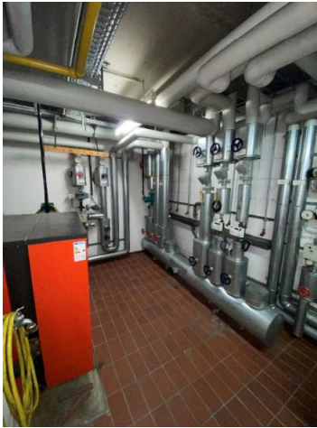
Heizungsverteiler
