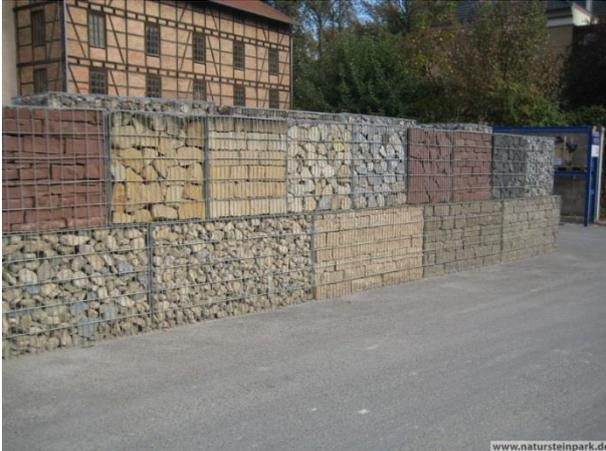
Abb. Bildbeispiel Füllmaterialien einer Gabione. Quelle: <https://www.natursteinpark.de/fileadmin/Bilder/a%29%20Mauern/az%29%20Sonstige%20Mauern/Gabionen-mit-Naturstein-verfuellte-Drahtkoerbe-01.jpg>
