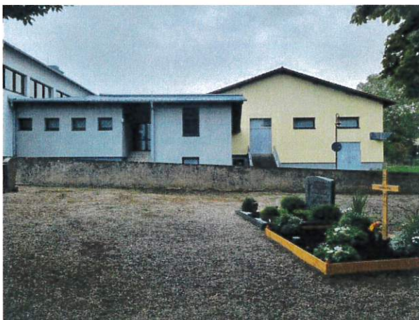
Unbefriedigende Randeingrünung zur Bebauung. Pflanzungen außerhalb sind sinnvoll.
