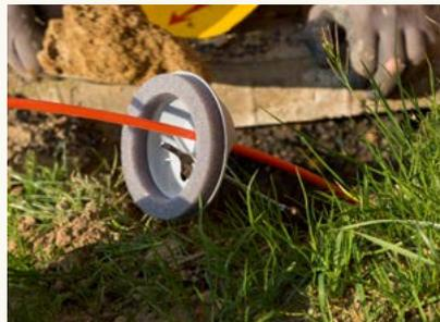
**3** Es erfolgt die Einspritzung der Abdichtungsmasse zur druckwasserdichten Verschiebung des Einführungslochs.
