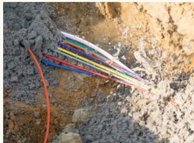
**3** Mithilfe des sog. Bodenverdrängungs-hammer wird die Glasfaser unter Garten bzw. Einfahrt hindurch bis zum Kopfloch an der Hauswand verlegt. Sollte der Einsatz nicht möglich sein, arbeiten wir in offener Bauweise. Die Möglichkeiten und Details sowie die Position des Kopfloches werden am Tag der Hausbegehung mit Ihnen besprochen. Vorgarten oder Einfahrt bleiben bei diesem Vorgehen unberührt.
