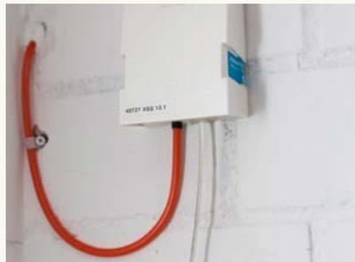
**11** Der Leitungsweg zwischen HÜP und GF-TA ist mittels Leerrohr oder Kabelschacht selbst vorzubereiten und muss am Tag der Aktivierung fertiggestellt sein. Der Weg zwischen HÜP und GF-TA darf die Länge von 20 m in Einfamilienhäusern und 30 m in Mehrfamilienhäusern nicht überschreiten. Der NT wird in unmittelbarer Nähe (0,3–0,5 m) des GF-TA installiert.
